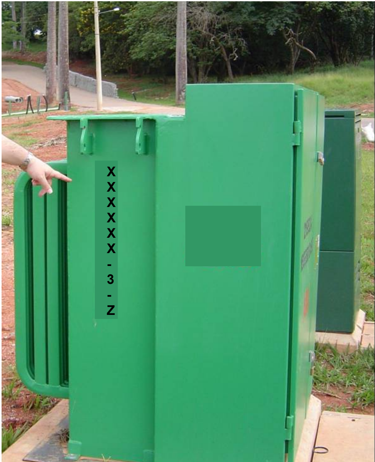
Figura 23: Local para pintura da numeração patrimonial:
