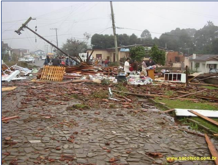
Figura 8 - Poste Caído- São Francisco de Paula
