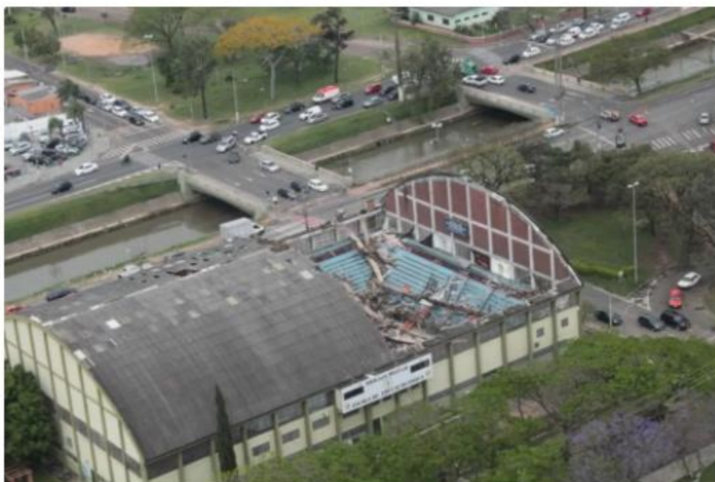
Laudo de engenheiro da Brigada Militar apontou que, além do desmoronamento da cobertura do ginásio da corporação, as estruturas (Foto: Deise Freitas)
